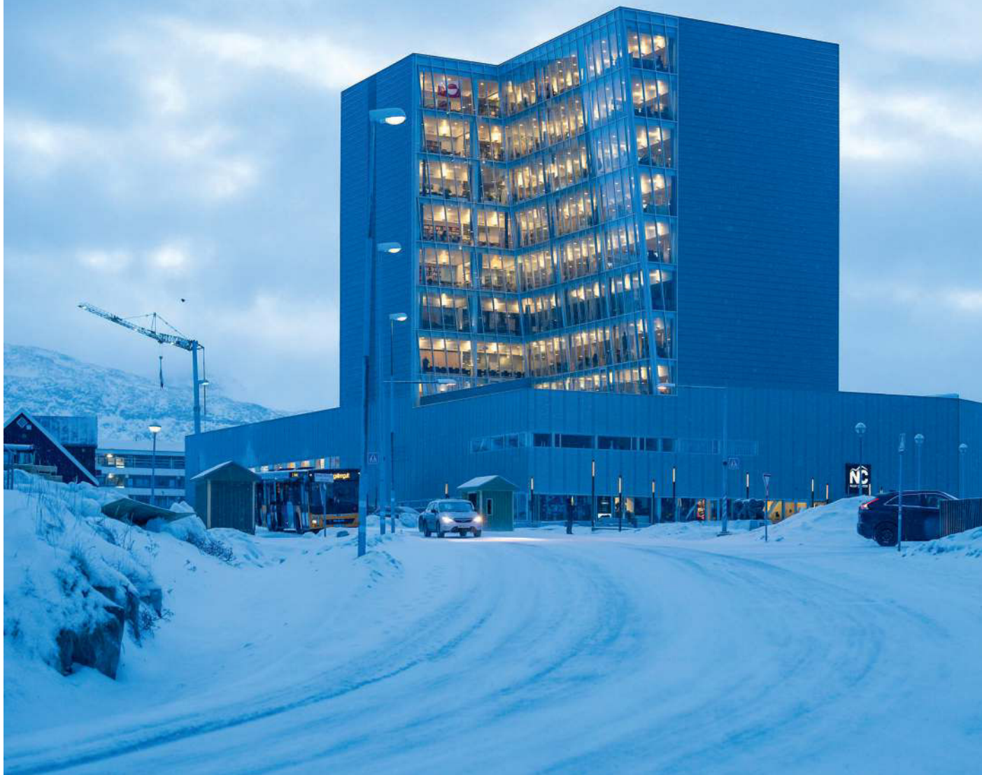
Au cœur de la ville, un petit centre commercial – le seul du pays – est installé dans le Nuuk Center. Les étages supérieurs du bâtiment abritent les bureaux où siège le gouvernement groenlandais.
